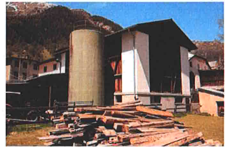
Neuzeitliche Eckpfeiler-Stallscheune Bis vor zwei Jahren landwirtschaftlich genutzt. Neu als Werkstatt genutzt.
