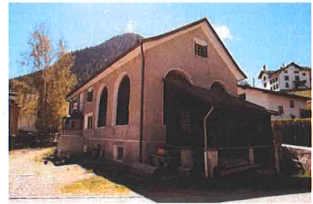
Gemauerte Stallscheune mit Rundbogenöffnungen. Umlaufend verputzte Hohlkehle Störende Anbauten.
