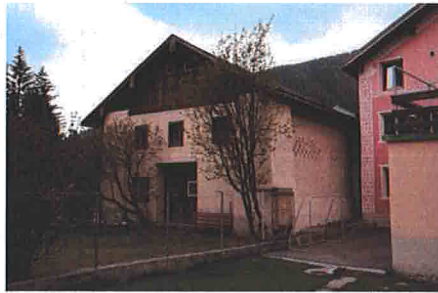
Ürsprünglich Eckpfeiler-Stallscheune Störend: Garageneinfahrt sowie nachträgliche Ausmauerung der Holzausfachung.
