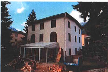
Gemauerte, befensterte Stallscheune Nähe zur Kirche. S-törender verglaster Anbau.
