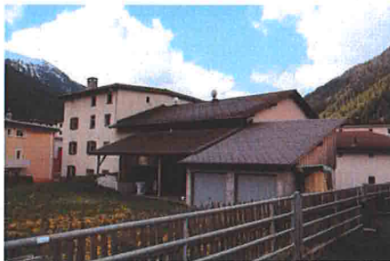
Sehr einfache, gemauerte und befensterte Stallscheune Grosses Volumen. Störende Anbauten. Nachträglich aufgestockt. Form nicht passend zum Wohnhaus.
