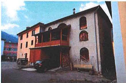
Gemauerte und befensterte Stallscheune Wichtige Lage an Hauptstrasse.
