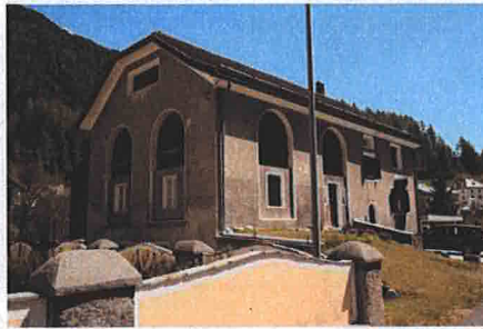
Gemauerte Stallscheune mit Rundbogenöffnungen, umlaufende verputzte Hohlkehle. Nachträgliche teilw. Ausmauerung der Rundbogenöffnungen störend.
