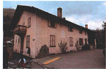
Ürsprünglich Eckpfeiler-Stallscheune Störend: Garageneinfahrt sowie nachträgliche Ausmauerung der Holzausfachung.
