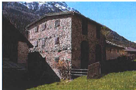
Stallscheune mit Befensterung und Bogenöffnungen Sehr seltener Rasapietra-Verputz ist bei Umbau zwingend zu erhalten.
