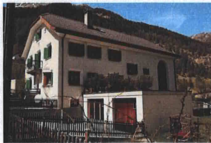
Gemauerte Stallscheune mit Rundbogenöffnungen. Umlaufende verputzte Hohlkehle. Flachdach Anbau störend.
