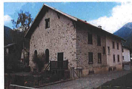
Gemauerte, befensterte Stallscheune Rasapietra-Verputz (beizubehalten).
