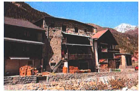
Gemauerte Stallscheune an exponierter Flusslage Garageneinbau störend. Zweigeschossige Laube flussseitig. Rasapietra_Verputz ist zu erhalten.
