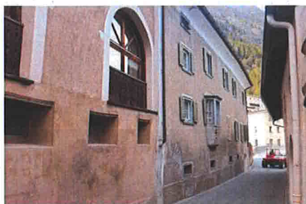
Gemauerte Stallscheune mit Befensterung. Teil einer Gebäudezeile entlang der Gasse.
