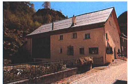
Stallscheune Teilweise Neubau (Holzausfachung, Dach, Betonplatte). Unter kantonalem Schutz
