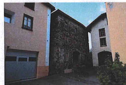
Gemauerte, befensterte Stallscheune mit hohen Bogenöffnungen Einzigartiger Rasapietra-Verputz zwingend beizubehalten.
