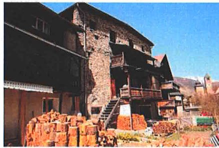
Gemauerte Stallscheune an exponierter Flusslage Garageneinbau störend. Zweigeschossige Laube flussseitig. Rasapietra_Verputz ist zu erhalten.
