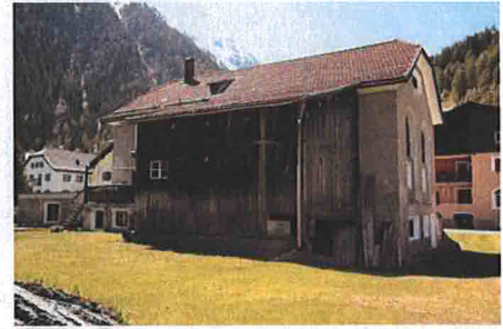
Gemauerte Stallscheune mit Rundbogenöffnungen, umlaufende verputzte Hohlkehle. Nachträgliche teilw. Ausmauerung der Rundbogenöffnungen störend.
