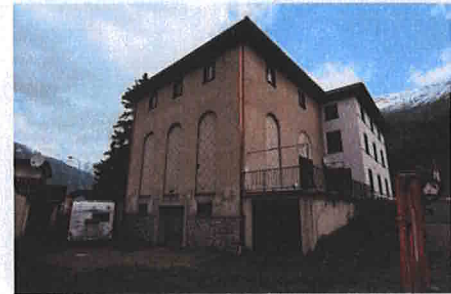
Gemauerte Stallscheune mit Bogenöffnungen Störend: Garagenanbau nord- sowie südseitig, Garagentor. Nachträgliche Verkleidung der Bogentore
